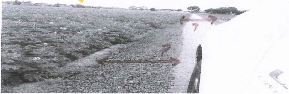
Photo n°4 : largeur du sentier supérieure à 3 mètres, les graviers roulent sur la terre.
